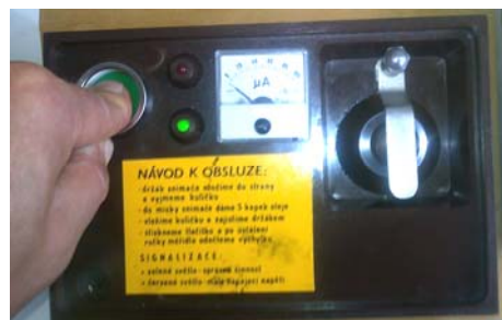
Kontrola prístroja pred meraním
