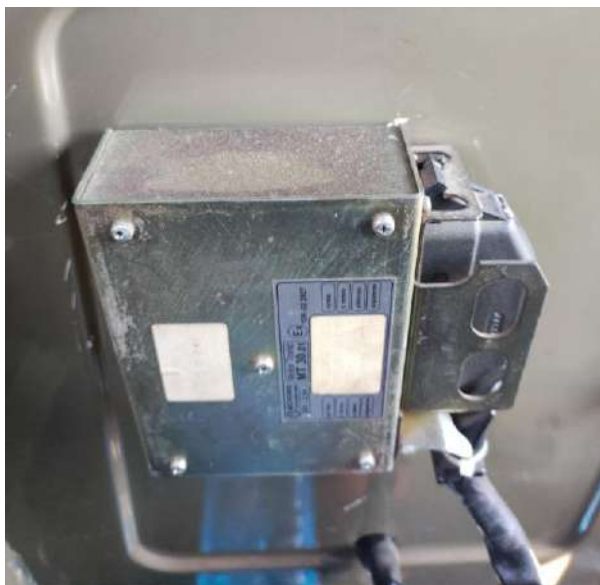
Riadiaca jednotka motora (za sedadlom vodiča).
