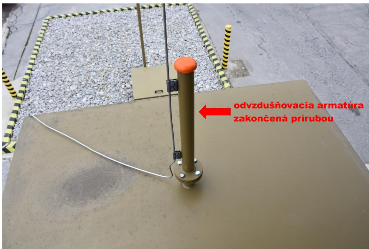
Obrázok č. 11. Detail odvzdušňovacej armatúry.
