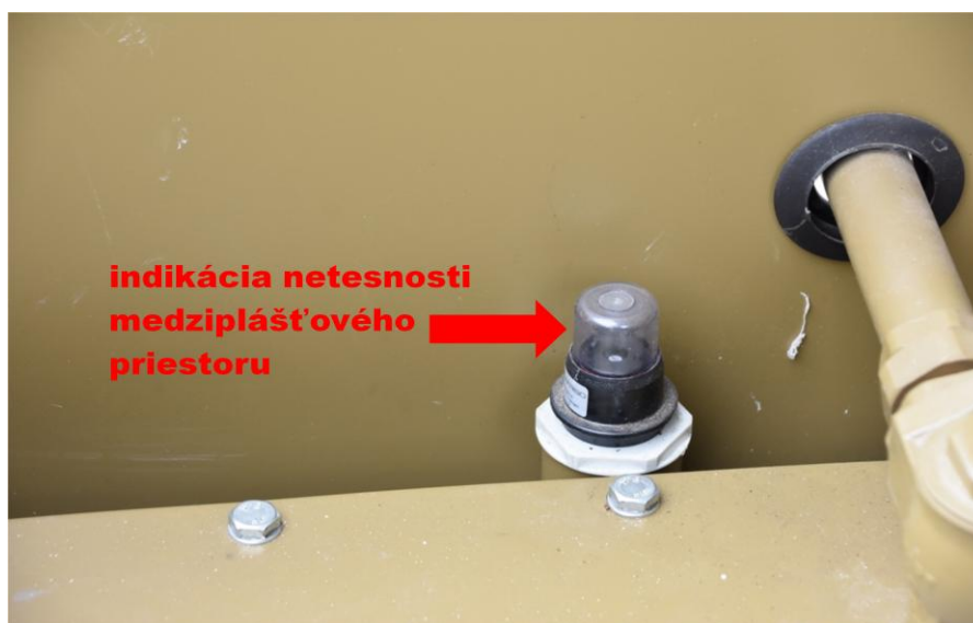
Obrázok č. 1. Indikácia netesnosti medziplášťového priestoru nádrží NDN 22 000.
