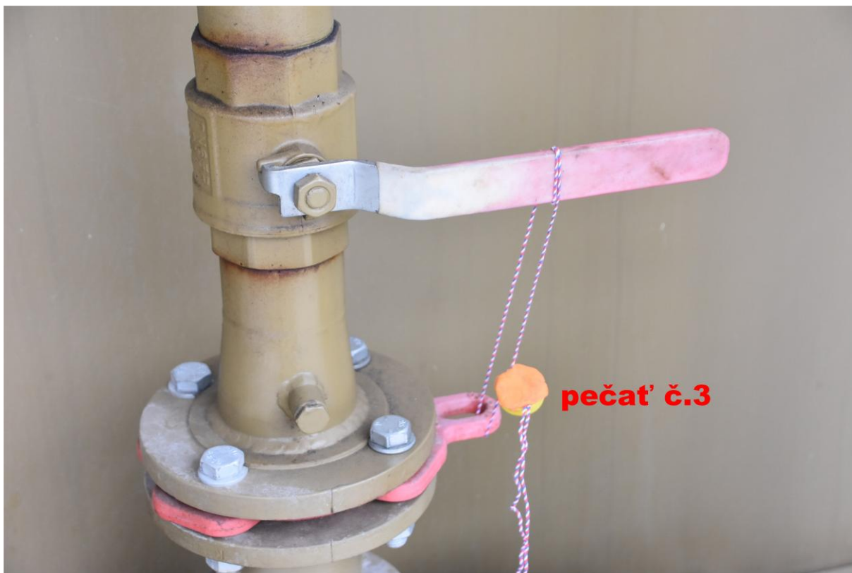
Obrázok č. 15. Detail umiestnenia pečate č. 3 na stáčacej/plniacej armatúre.
