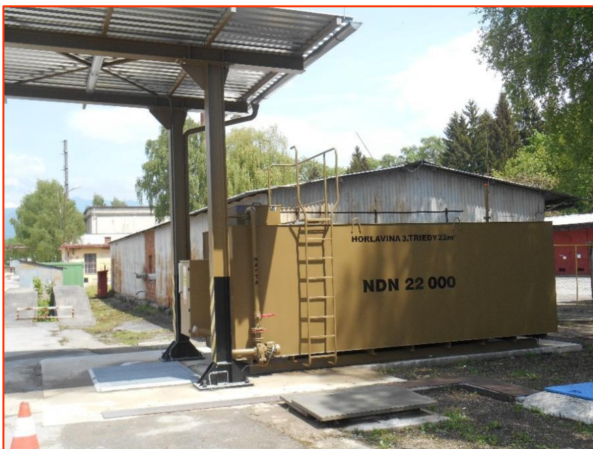
Obrázok č. 23. Nadzemná dvojplášťová nádrž na uskladnenie motorových palív s vlastnou výdajnou skupinou.
