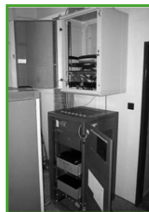
Laboratórium s ústredňou Tesla UE 300 (hore) a UE 60 s prepojovacím poľom (dole)
