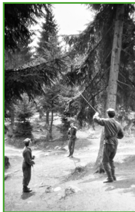
Výstavba linkového spojenia so súpravou LK-6 v zalesnenom teréne
